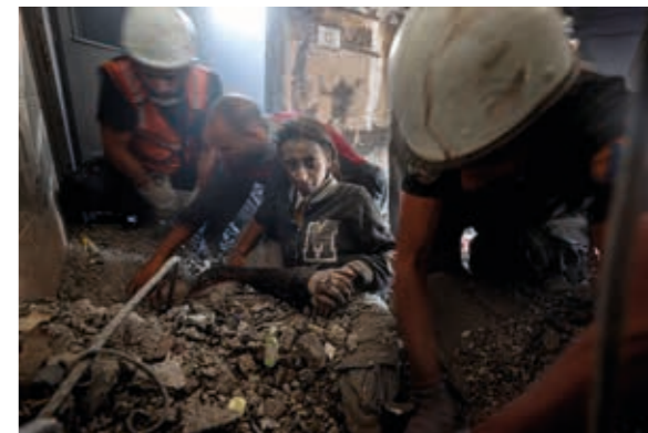
Una dona i una nena de 13 anys, May Saad, són rescatades amb vida sota les runes de l'edifici destruït
